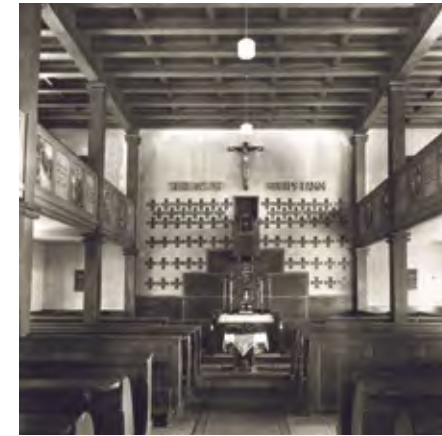
Zustand der evangelischen Kirche in Ittersbach, Friedrich-Dietz-Straße 1, nach 1932 (Landkreis Karlsruhe).
