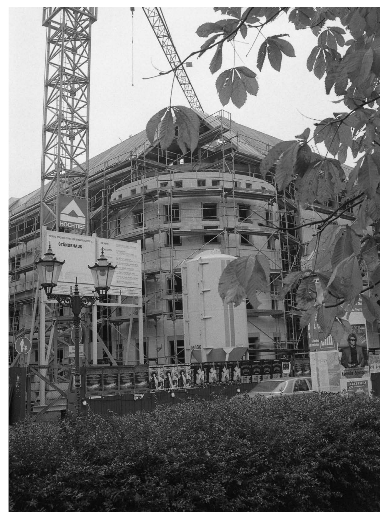
04 Die Baustelle des Neuen Ständehauses am 27. Oktober 1992 (StadtAK 8/Bildstelle I 6311, 24, Foto: Dietmar Hamel)
