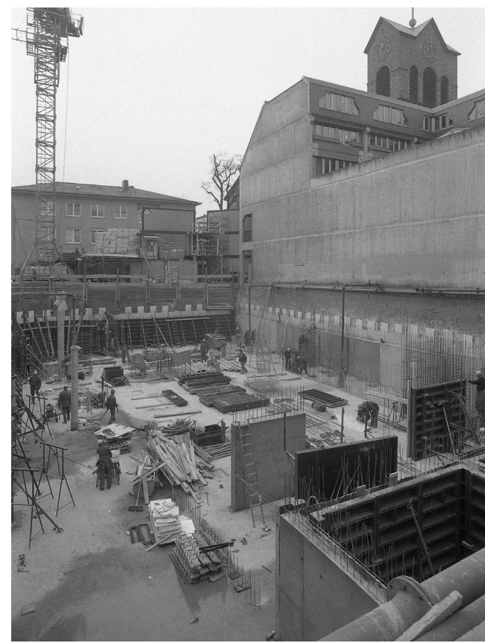
03 Die Baustelle des Neuen Ständehauses am 26. Februar 1992 (StadtAK 8/Bildstelle I 6179, 33, Foto: Dietmar Hamel)
